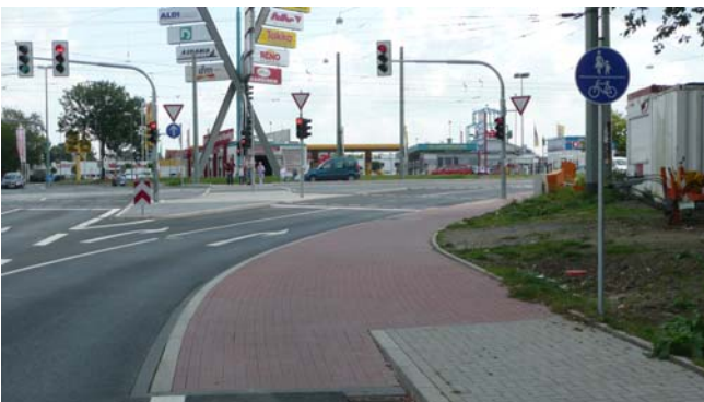
Foto 3 und 4: Genau da, wo die Trennung erforderlich ist, wird die Trennung von Fahrzeug- und Fußgängerkehr aufgehoben.
