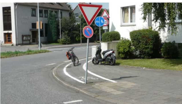
Foto 5: Hordeler Straße. Soll das ein Radweg sein? Und wo ist der Fussweg?
