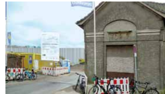
Torhaus 7 auf dem Neubauweg zur Bessemer Straße
