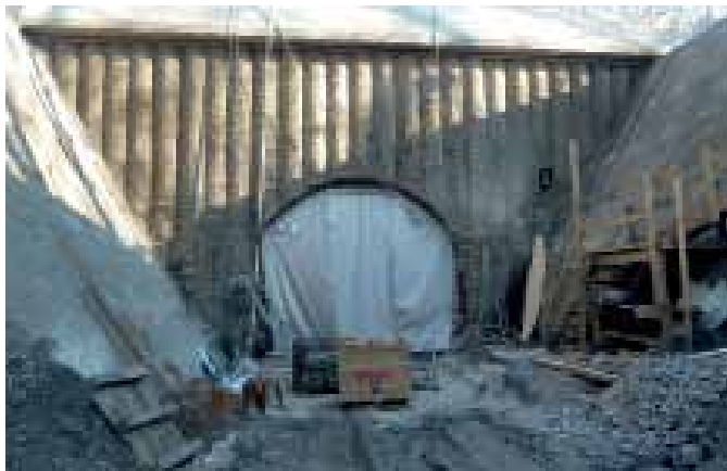
Springorum-Trasse – Westseite nach dem Durchstich
